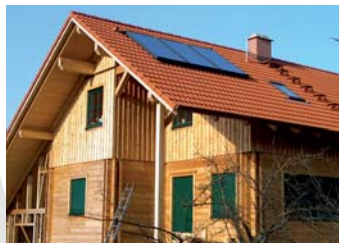
sunnySol UP - Aufdachmontage
